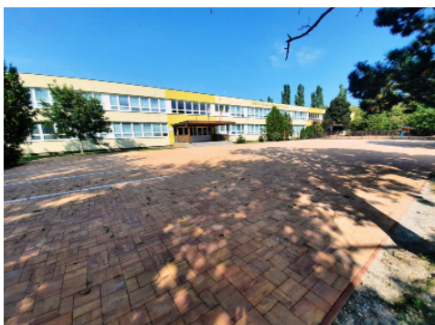
Iskolaudvar a felújítás után
